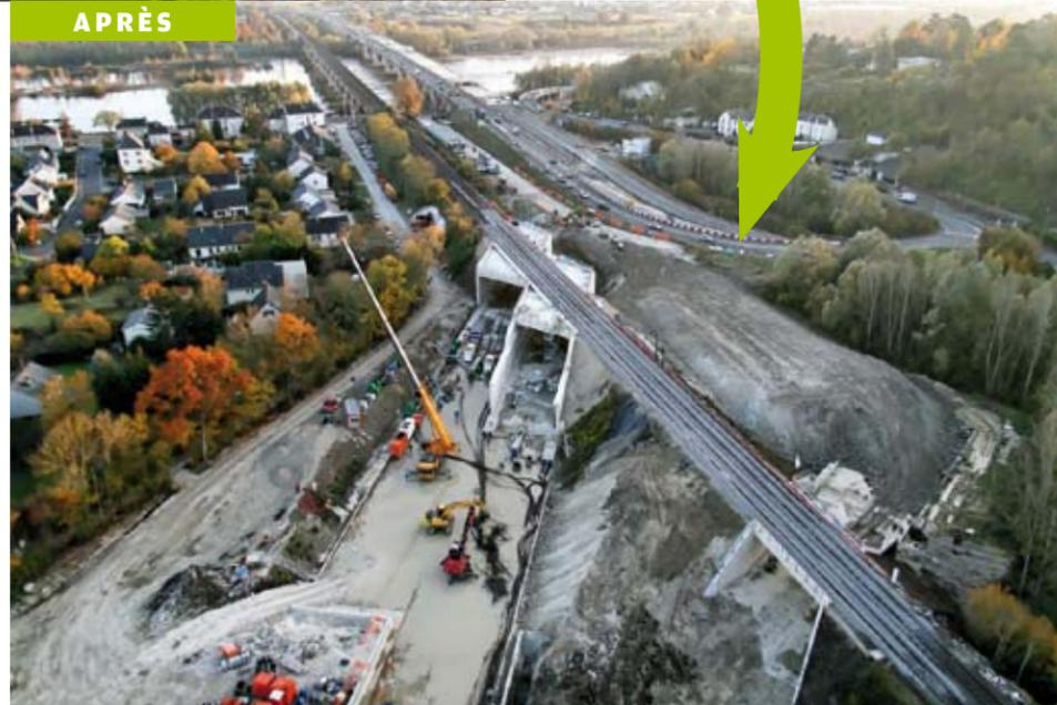
Au total, 23 500 m<sup>3</sup> de matériaux ont été déplacés, soit l'équivalent d'une hauteur de 25 m sur la surface d'un terrain de rugby.
