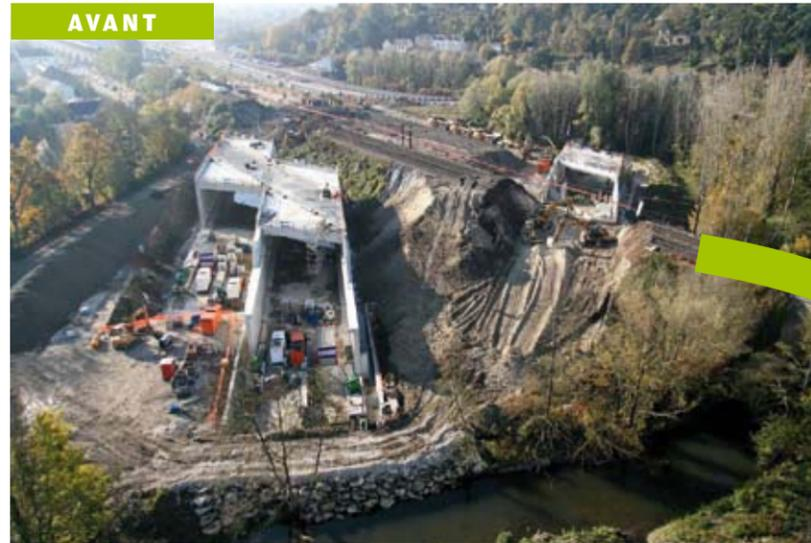
Le franchissement de la voie ferrée Tours-Le Mans par le périphérique impose la construction d'un ouvrage spécifique : le pont-rail.
