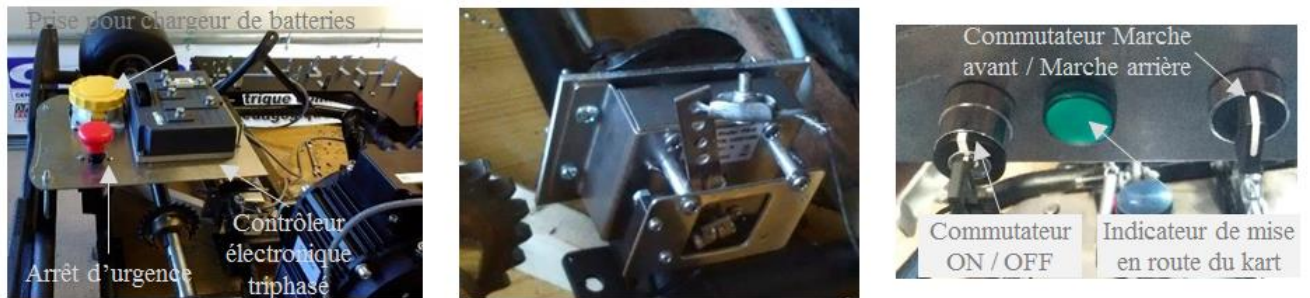
(c) Fixation du contrôleur « SEVCON GEN4 G4845 », du bouton d'arrêt d'urgence et de la prise du chargeur de batteries
