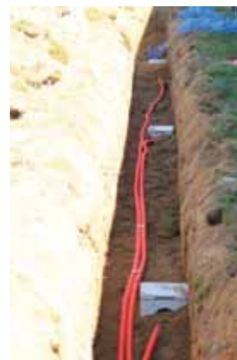
Vue du puits après enfouissement et implantation capteurs thermiques.
