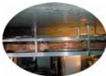
4 – Assemblage de la structure
